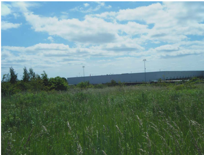
Lokalplanområdet med Carlsbergs bebyggelse i baggrunden
